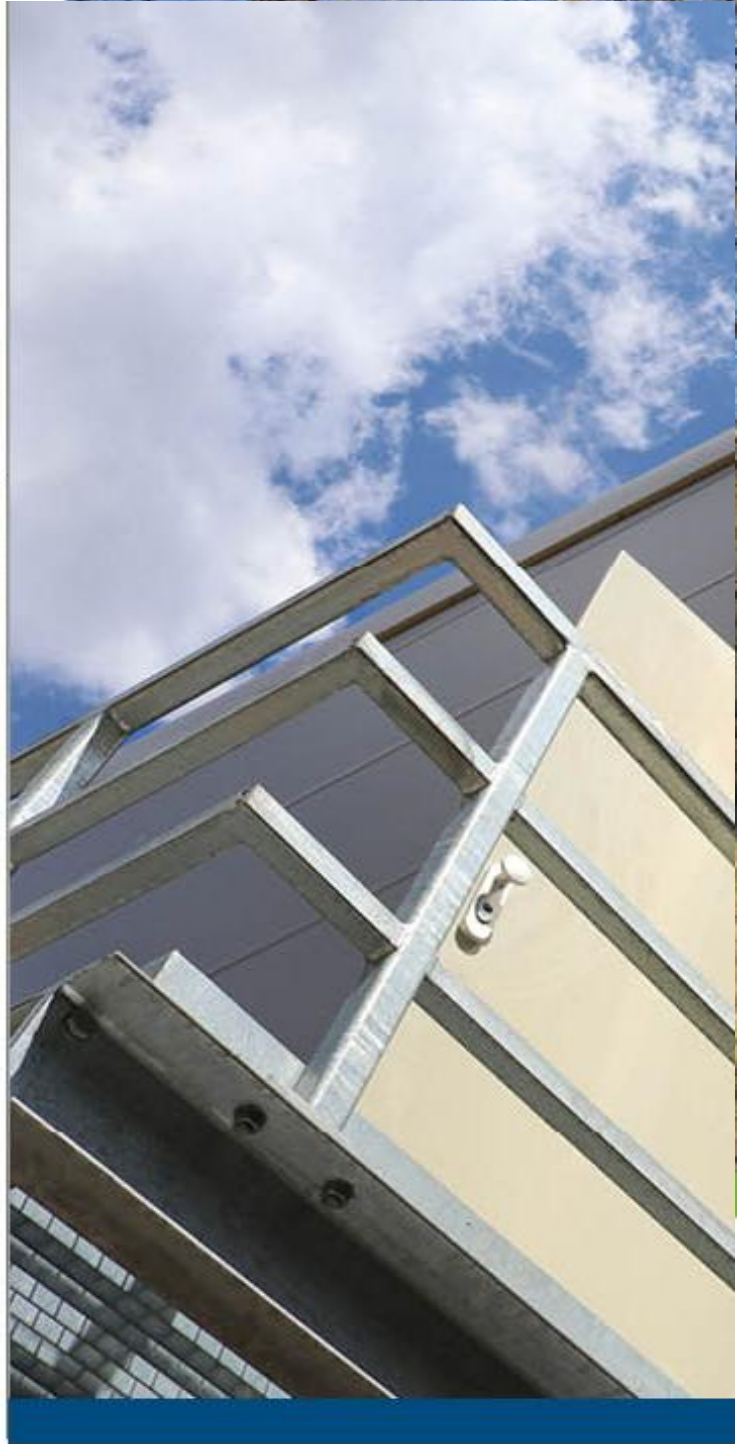
Werkserweiterung in Bernlohe mit der neuen Halle 18, die Fassade wurde mit Zenexo® veredelt.
